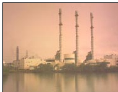
Power Plant, Bahia Las Minas
